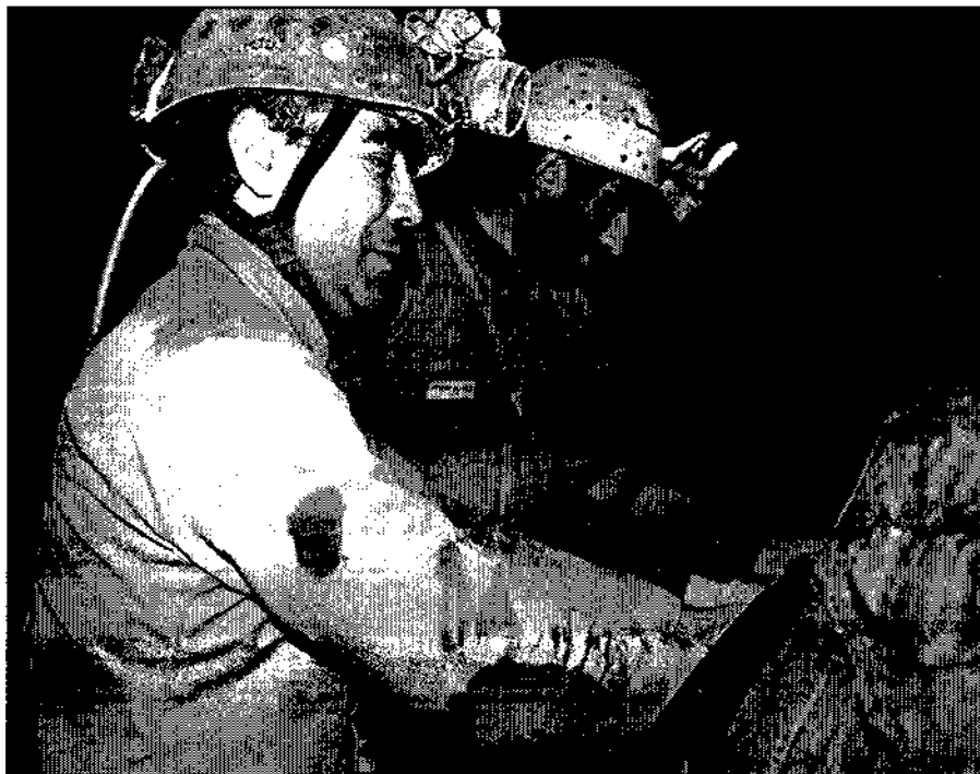
Fixation du tuyau en PET pour la captage en eau potable du village de Mayronnes.
